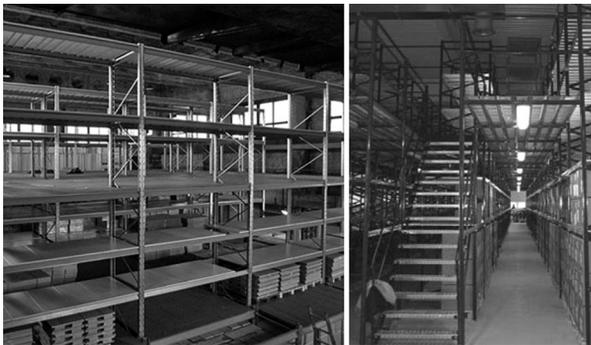
Рис. 4.33. Мезонинные/многоэтажные стеллажи
