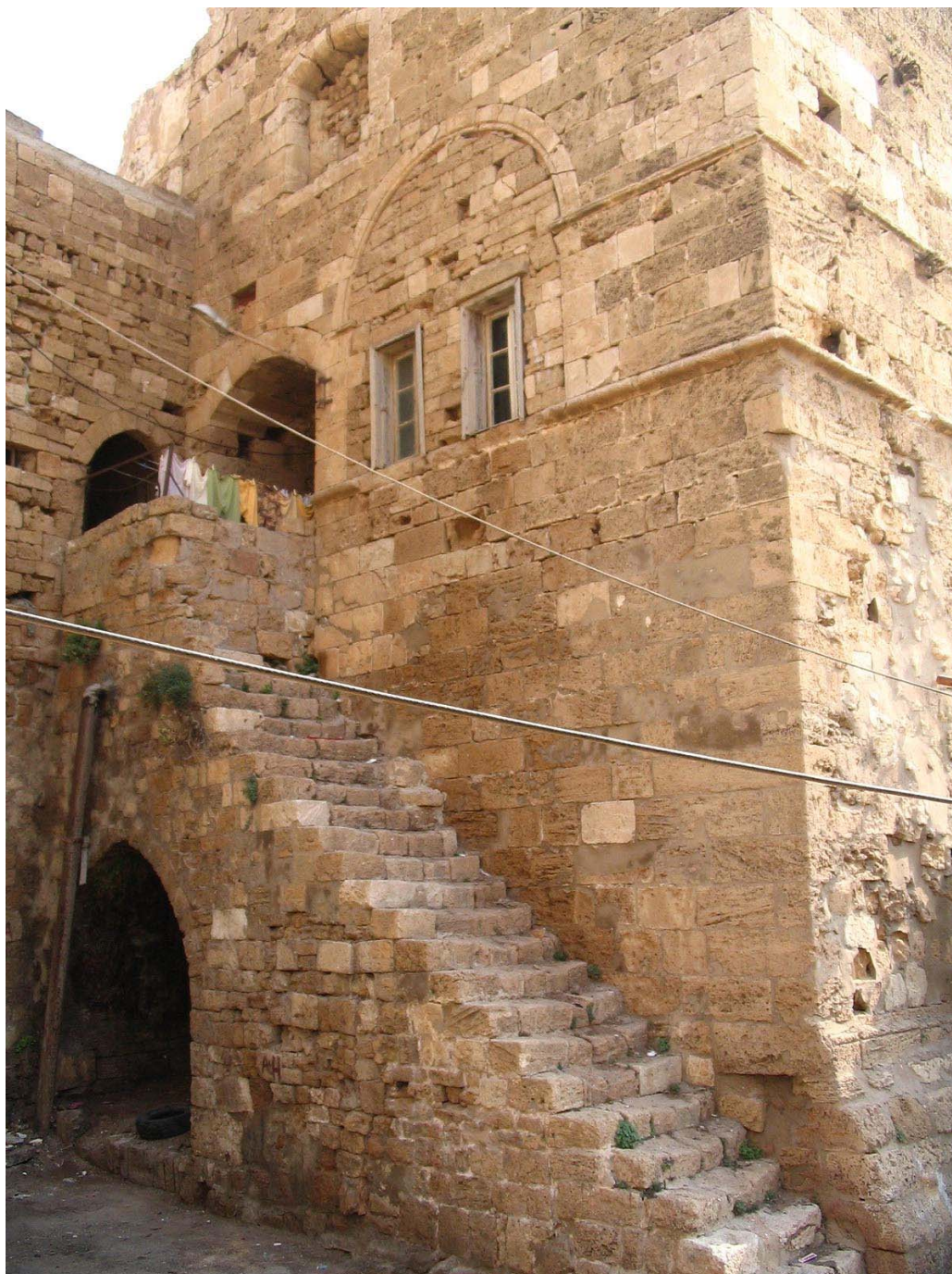
Тартус, башня и участок стены, переоборудованный в жилище
