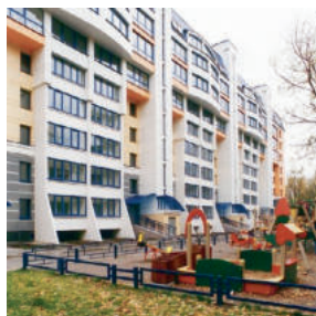
Рис. 3. Северное Тушино, Москва. Реконструкция панельной 5-этажки
