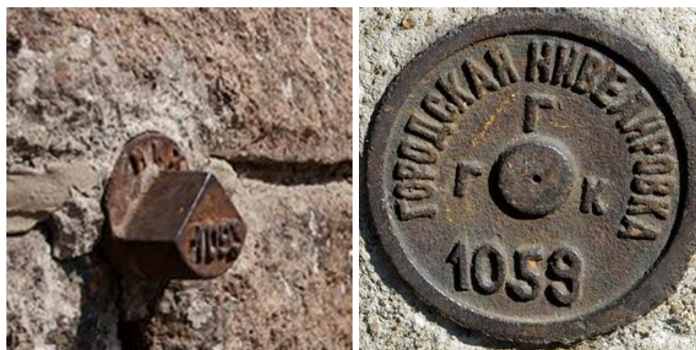
Рисунок 8 – Обозначение на местности пунктов нивелирной сети: стенной репер (слева), стенная марка (справа)
