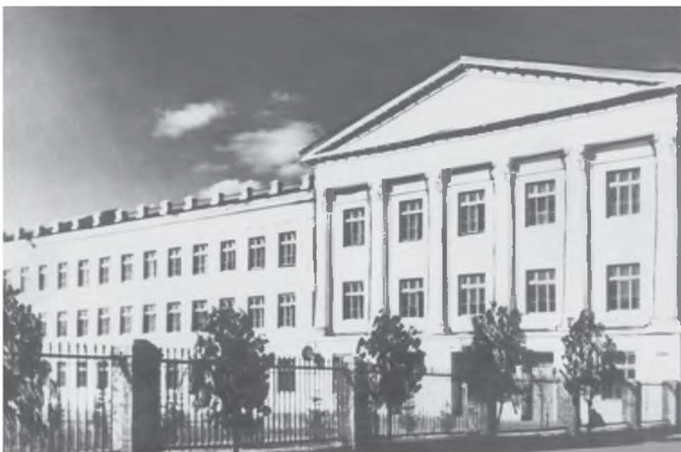
Вучэбны корпус Мінскага юрыдычнага інстытута, вул. Акадэмічная, 4
