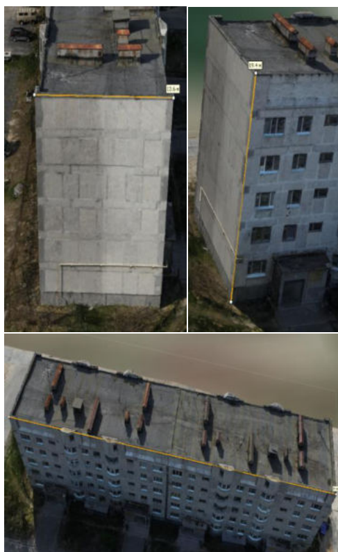
Рис. 5. Измерения габаритных размеров 3D-модели
