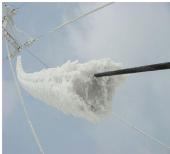
Рисунок 33. - Отложение на проводах гололеда и изморози
