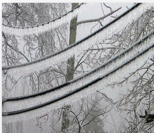
Рисунок 33. - Отложение на проводах гололеда и изморози
