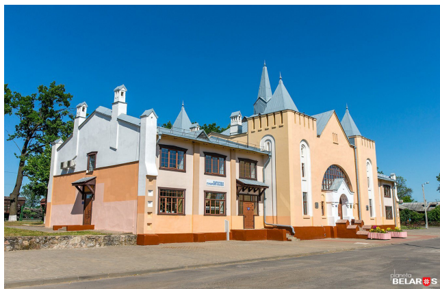
Рис. 4. Железнодорожный вокзал в Бигосово после реконструкции. Фотография. 2018 г.
