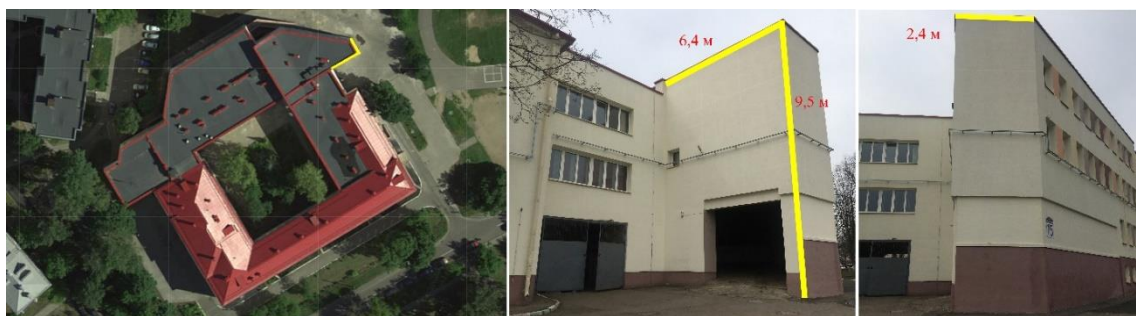
Рис. 1. Стена, предназначенная для установки системы вертикального озеленения
