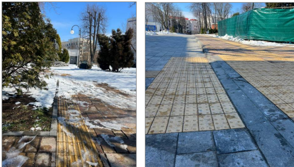
Рисунок 17 – Продолжение тактильной плитки
