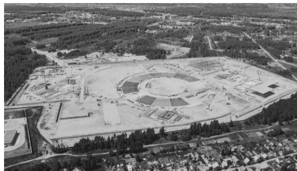
Рис. 1. Вид на строительную площадку ЦКП «СКИФ» (июль 2023 года)
