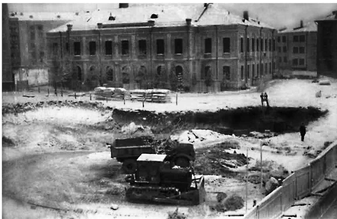
Рис. 5. Начало строительства корпуса физического факультета.
