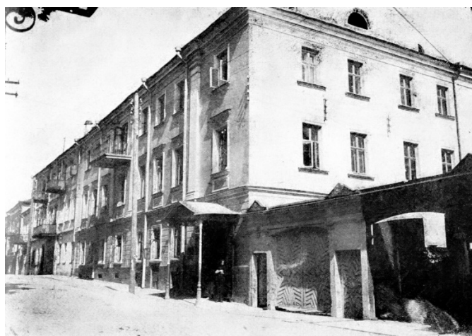
Рис. 1. Здание Института белорусской культуры по ул. Революционной, 21. Фотография 1926 г. [8, с. 17]
