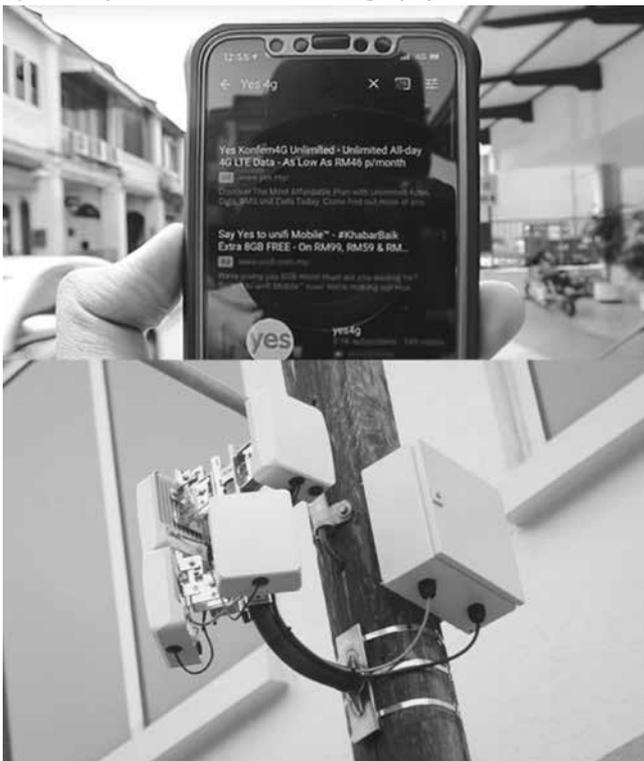
Рисунок 3 – Оборудование пилотной сети Terragraph в г. Пенанг (Малайзия). Источники: TechNave, YTL
