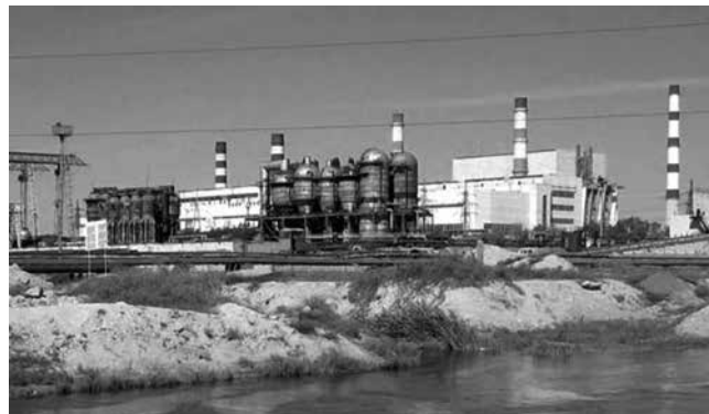
Рисунок 4 – БН-350 – первый промышленный реактор на быстрых нейтронах с натриевым теплоносителем в СССР
