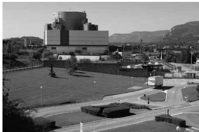
Рисунок 5 – Здание реактора Суперфеникс, самого мощного построенного реактора на быстрых нейтронах.
