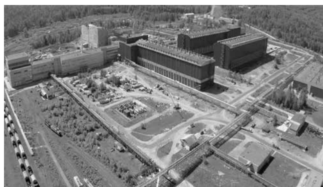
Рисунок 10 – Комплекс централизованного хранения ОЯТ на ФГУП «ГХК»
