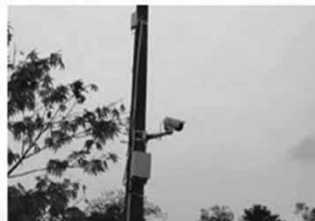
Рисунок 13 – Использование Wi-Fi для организации многоканального видеонаблюдения
