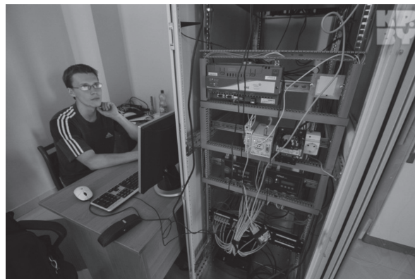
Управлением всего хозяйства занимается специальная система автоматического управления интеллектуального здания – так называемая система «умный дом»
