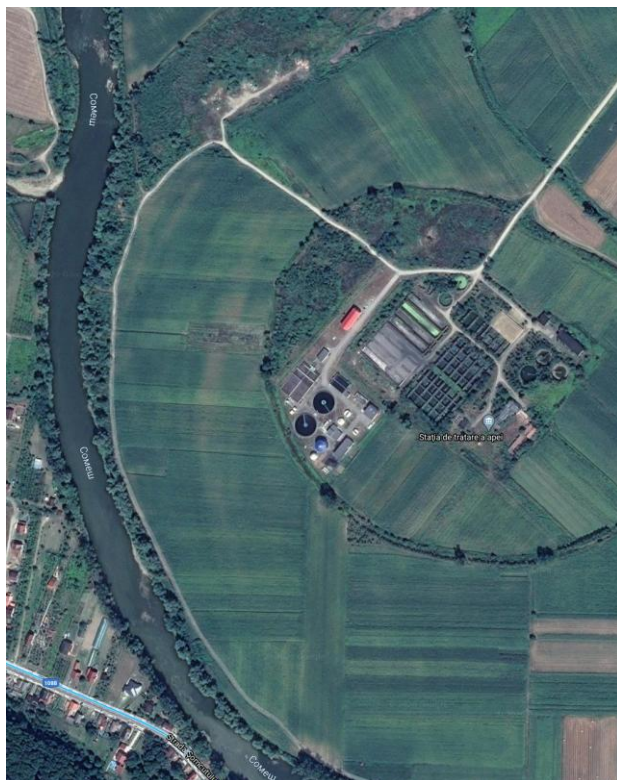
Рисунок 11 – Очистные сооружения вблизи г. Деж [1]
