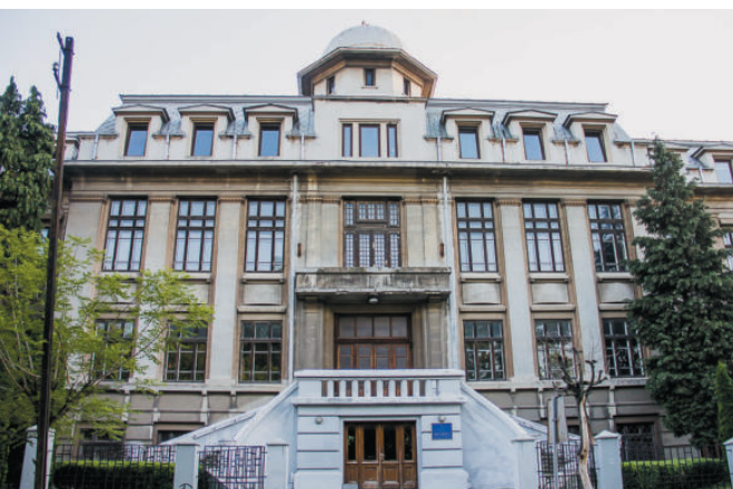
Корпус № 3 Черновицкого университета
