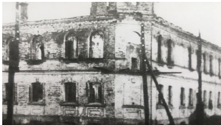
рис.2 Разрушенное здание Витебской учебно–производственной мастерской (снимок 1946 г.)
