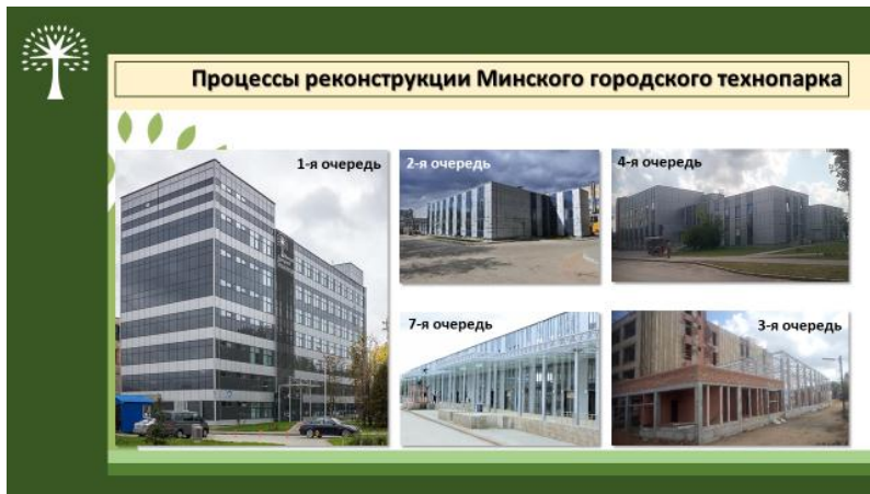
Рисунок 1. Процессы реконструкции Минского городского технопарка, включающие различные очереди строительства и реконструкции
