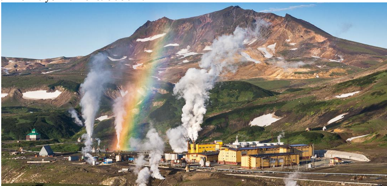
Рисунок 2.5. Мутновская геотермальная электростанция
