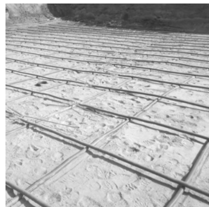
Рис. 3. – Горизонтальное армирование песчаной подушки
