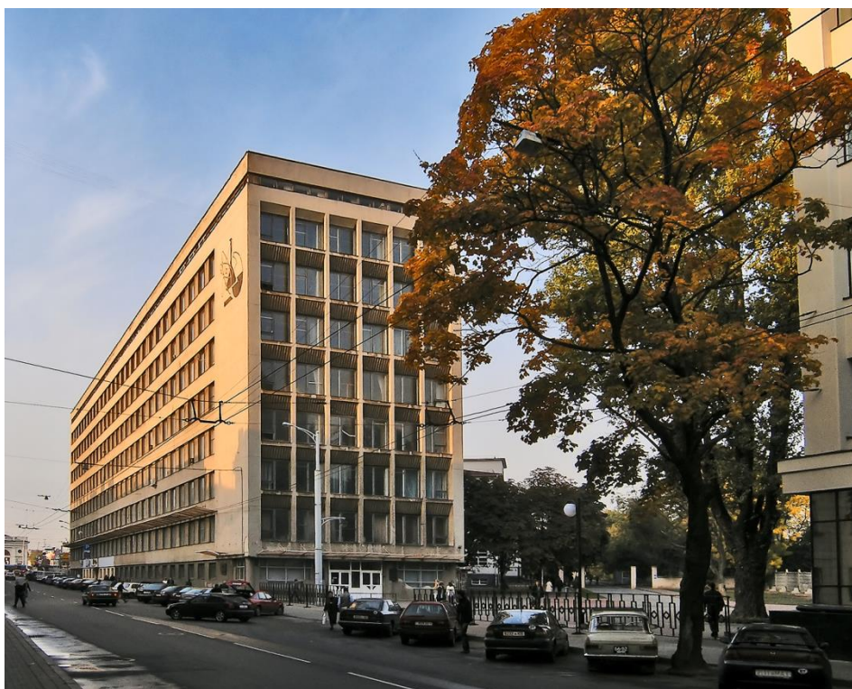
Здание химического факультета по ул. Ленинградской
