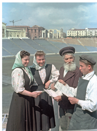
Строители минского стадиона «Динамо». 1954 г.
