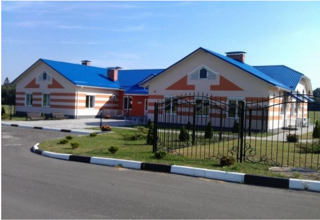
Рис. 3. Здание станции фонового мониторинга Березинского заповедника
