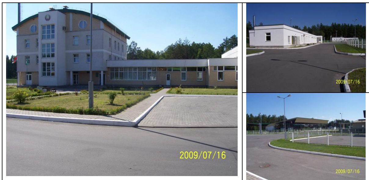
Рисунок 4 – Комплекс из 4-х зданий, отапливаемых теплонасосной геотермальной установкой на пограничном и таможенном переходе «Новая Рудня». Установка смонтирована в одном из помещений в одноэтажном сооружении, изображенном справа вверху на ближнем плане.
