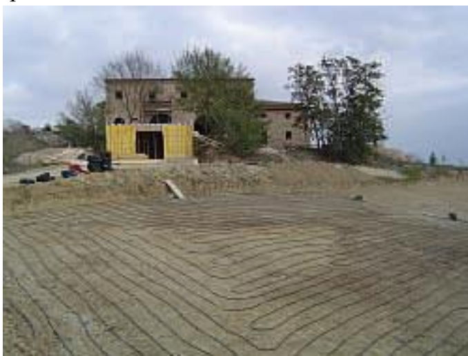
Рисунок — Горизонтальный циркуляционный контур.
