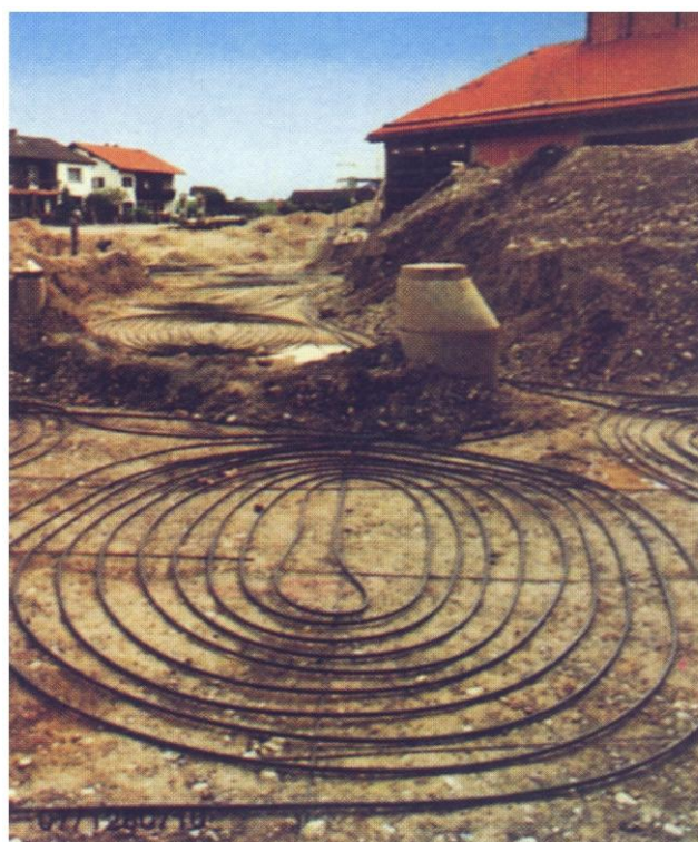
Рис. . Укладка пластмассовых труб с тепловым насосом горизонтальной схемы использования подземного тепла, Швейцария.
