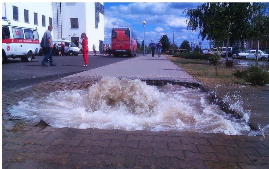
Рисунок 4.3 – Проявление техногенной суффозии образовавшейся в результате прорыва водопроводной трубы [27]
