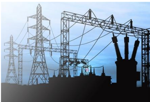
Рис. 6.30. Общий вид подхода к подстанции с элементами управления
