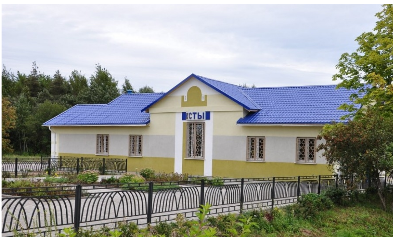
Рисунок 2 – Железнодорожная станция Ксты в Полоцком районе
