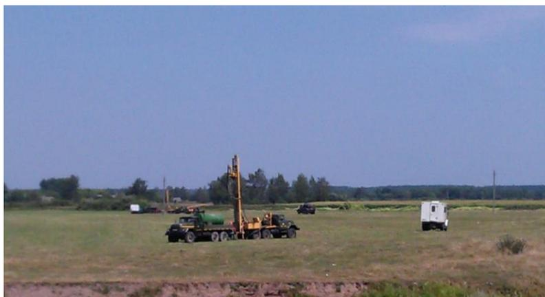
Рисунок 2.5 – Бурение взрывных скважин с промывкой водой
