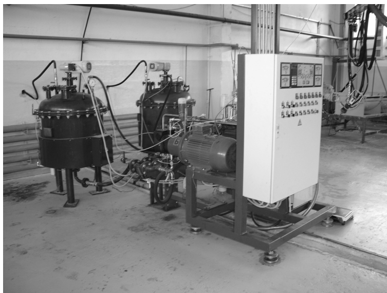
Рис. 1. Комплекс оборудования для серийного производства теплоизоляционных изделий из жесткого пенополиуретана
