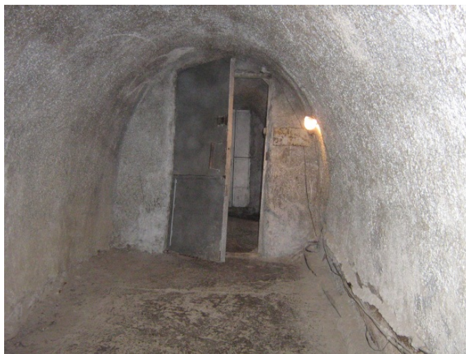
Рисунок 1 Переоборудованный второй вход (выход) в пещеру Кунгурская (Средний Урал) (здесь и далее фото автора)
