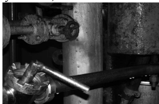
Рисунок 3. Негерметичность линии распределения пара в производственном цеху
