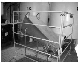
Рисунок 2. После демонтажа теплоизолирующего покрытия понадобилось установка ограждения, т.к. температура поверхности оборудования достигает 70 °С
