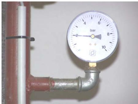
Рис. 8.3 – Манометр для контроля давления в системе
