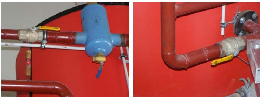
Рис. 8.4 – Вентили прямого и обратного потока
