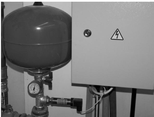
Рис. 8.9 – Манометр и шкаф включения установки повышения давления
