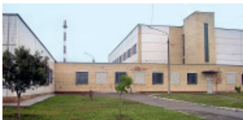
Фото 2. Здание канализационной станции КНС № 24 (д. Новый Двор), отапливаемой теплонасосной установкой
