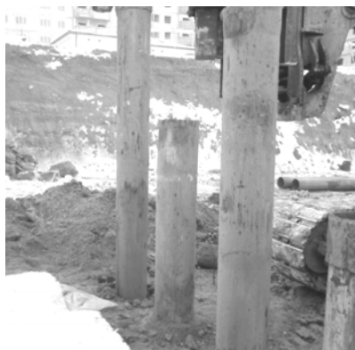
Рис. 2 – Устройство вертикальных армирующих элементов
